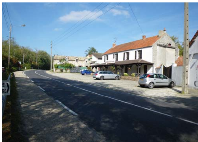
L'ancienne auberge de poste [CMP-21]
