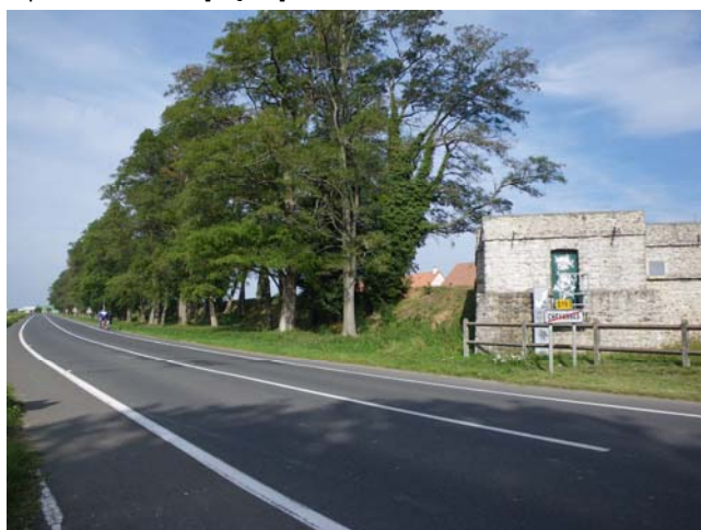
Siphon de la D 153 [AQ-28]
