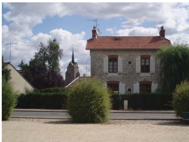
Ancienne station de Moigny [MC-18]
