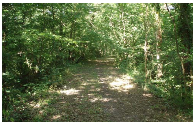
Remblai, derrière la station de pompage [MC-11]
