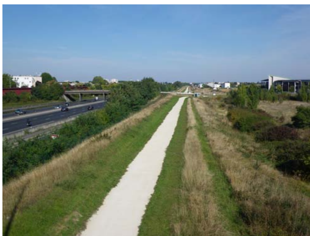
Voie verte parallèle à l'autoroute A6 [AQ-65]
