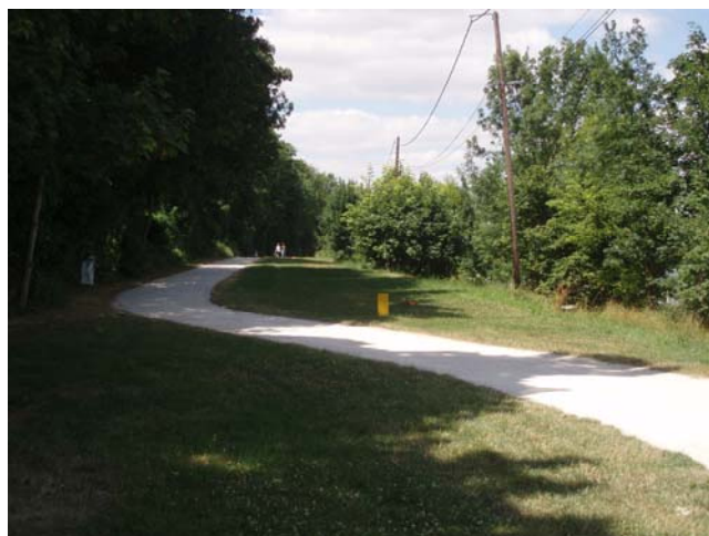
En aval de l'écluse d'Evry [SH-13]
