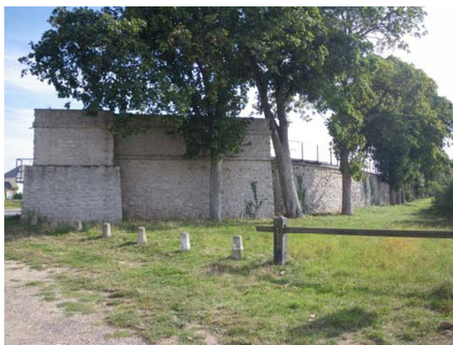
Siphon de la D 153 [AQ-27]
