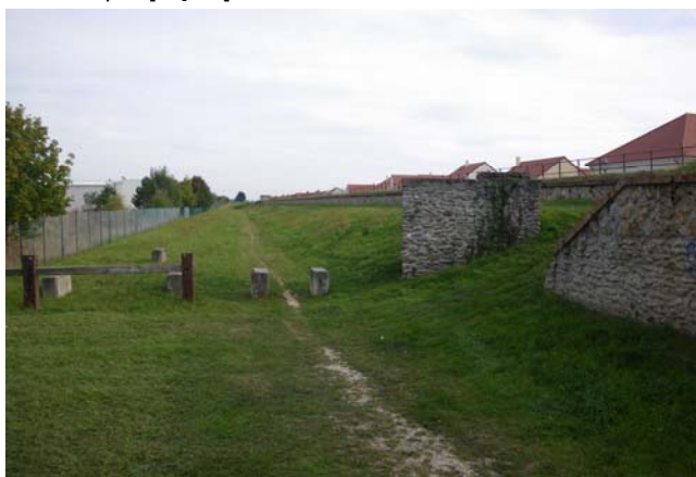
Intersection avec la rue des Malines [AQ-55]
