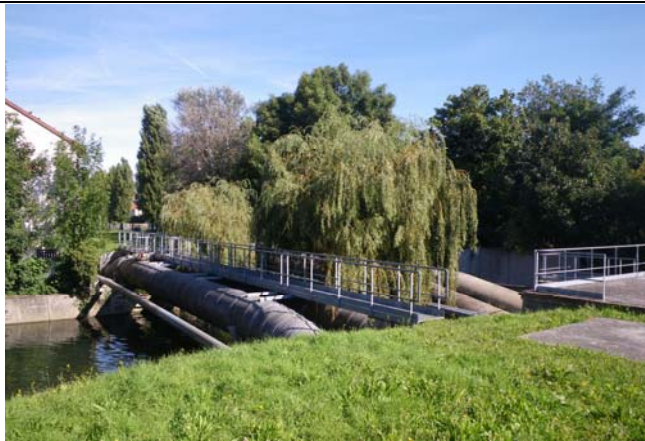
Pont-aqueduc sur l'Orge, avenue du Bellay [AQ-75]
