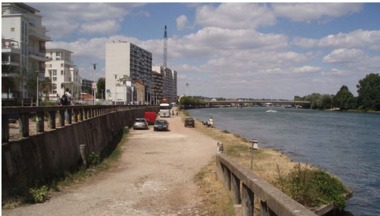
Port sous le quai Gambetta [SH-21]
