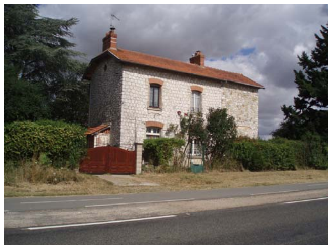
Ancienne station de Courances-Dannemois [MC-22]
