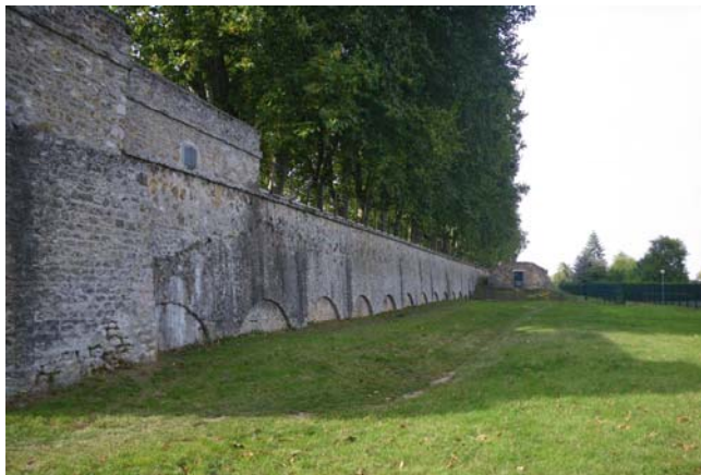
Siphon de l'avenue de la Jeannotte [AQ-37]
