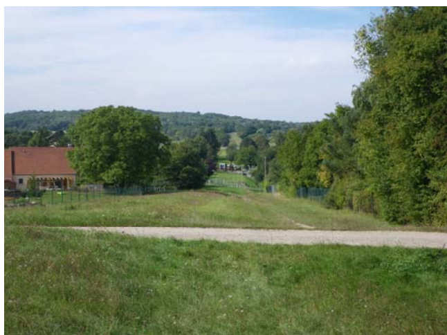
Siphon de l'Ecole, versant est [AQ-07]
