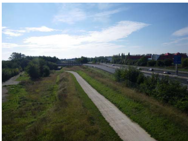
Voie verte parallèle à l'autoroute A6 [AQ-64]
