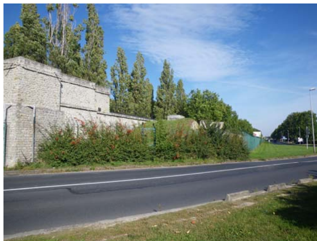
Siphon de l'avenue Joliot-Curie [AQ-60]
