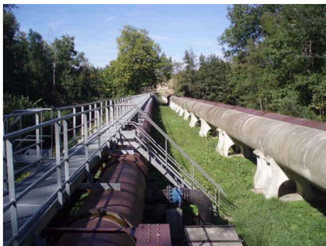
Pont-aqueduc sur le marais de l'Essonne [AQ-92]
