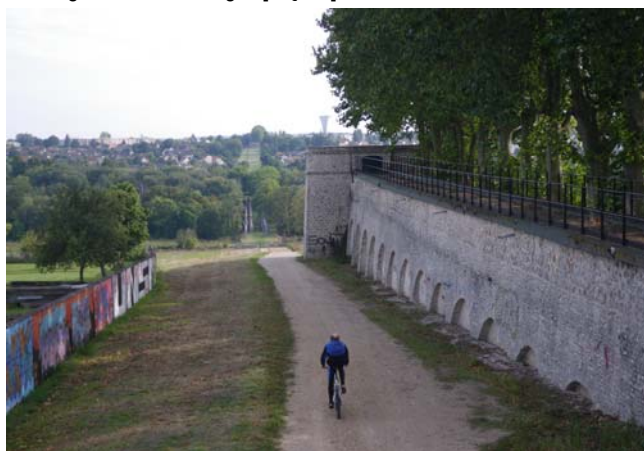
Siphon de l'Essonne, route de Villoison [AQ-45]
