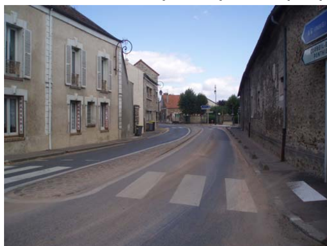
Traversée du bourg sur la chaussée de la RD 948 [MC-47]
