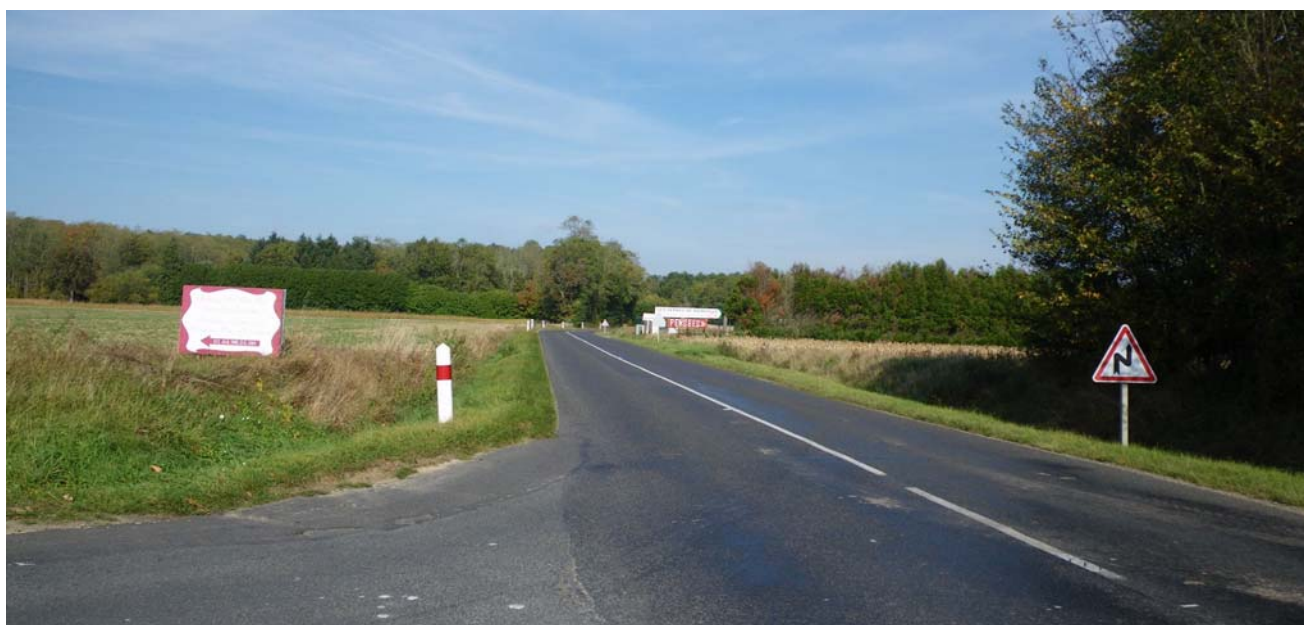
D 948, intersection avec la route de Beauvais [CMP-38]
