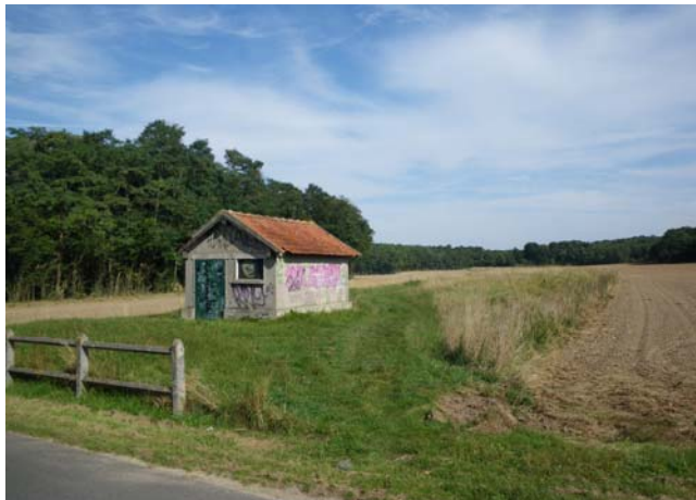
Intersection avec la route de Noisement [AQ-18]
