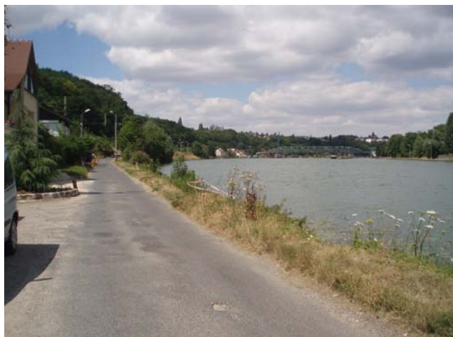
En amont du barrage du Coudray [SH-03]
