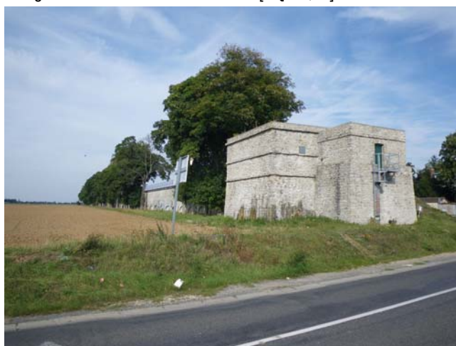
Siphon de la D 74 [AQ-26]
