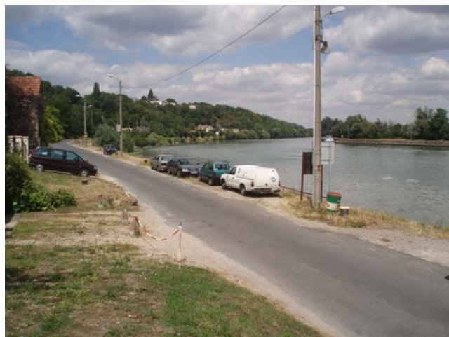
Au barrage du Coudray [SH-04]
