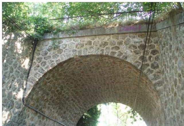
Viaduc au-dessus de la route de Buno [MC-38]
