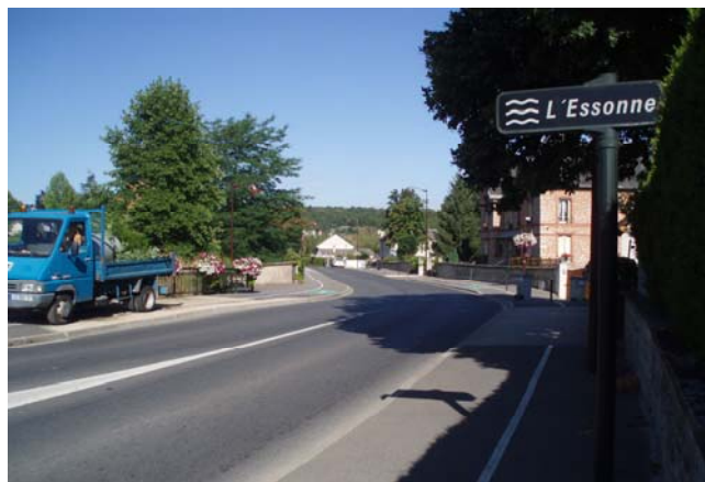
Passage de l'Essonne sur la chaussée de la RD 837 [MC-03]
