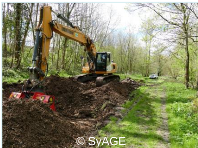
Terrassement et criblage
